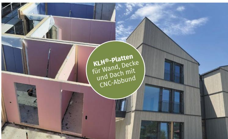
KLH®-Platten für Wand, Decke und Dach mit CNC-Abbund
